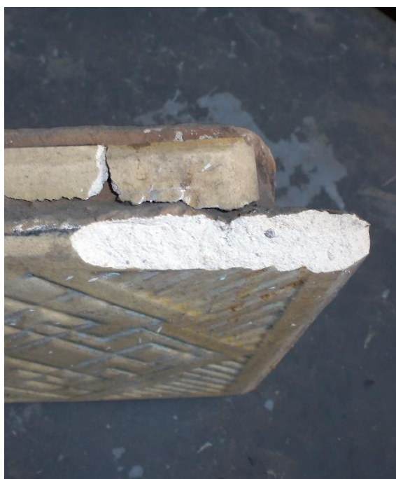
Fot. nr 10, 11, 12 – Kossakówka – Plac Kossaka 4, Kraków. Na górnym zdjęciu kafel licowy z dekoracją geometryczną oraz widoczna na odwrociu sygnatura spółdzielni „KAFEL”. Na dole po prawej stronie - odłamany fragment narożnika ukazujący budowę kafla – czerep z czerwonej gliny pokryty angobą ze szlachetnej białej glinki, która stanowi podłoże kremowego szkliwa. Na dolnym lewym zdjęciu odłamana krawędź kafla pieca nr 4 lub 5 wskazująca na to, iż cały kafel był odlany z białej mieszanki gliny. Te dwa fragmenty ukazują, że w początkowym okresie produkcji spółdzielni „KAFEL” (po 1927 r.) kafle mogły być produkowane w różny sposób. fot. Andrzej Karbowski – kwiecień 2021 r.
