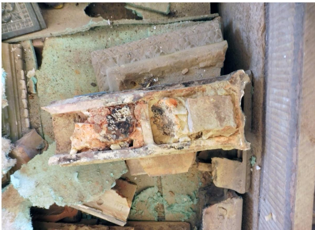
Fot. nr 5, 6 – Kossakówka – Plac Kossaka 4, Kraków. Fragment gzymsu pieca nr 1 z nieusuniętymi wylepkami gliny i fragmentu cegły. fot. Andrzej Karbowski – styczeń 2021 r.
