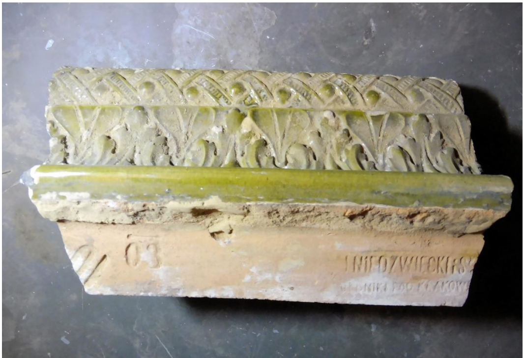
Fot. nr 7, 8 – Kossakówka – Plac Kossaka 4, Kraków. Górne zdjęcie – spudrowana warstwa angoby straciła całkowicie kształt reliefu. Na dole fragmenty sygnatury „J. Niedźwiecki, Dębники pod Krakowem” na kołnierzu gzymsu środkowego (widoczny, dobrze zachowany ornament). Fot. Andrzej Karbowski – styczeń, luty 2021 r.
