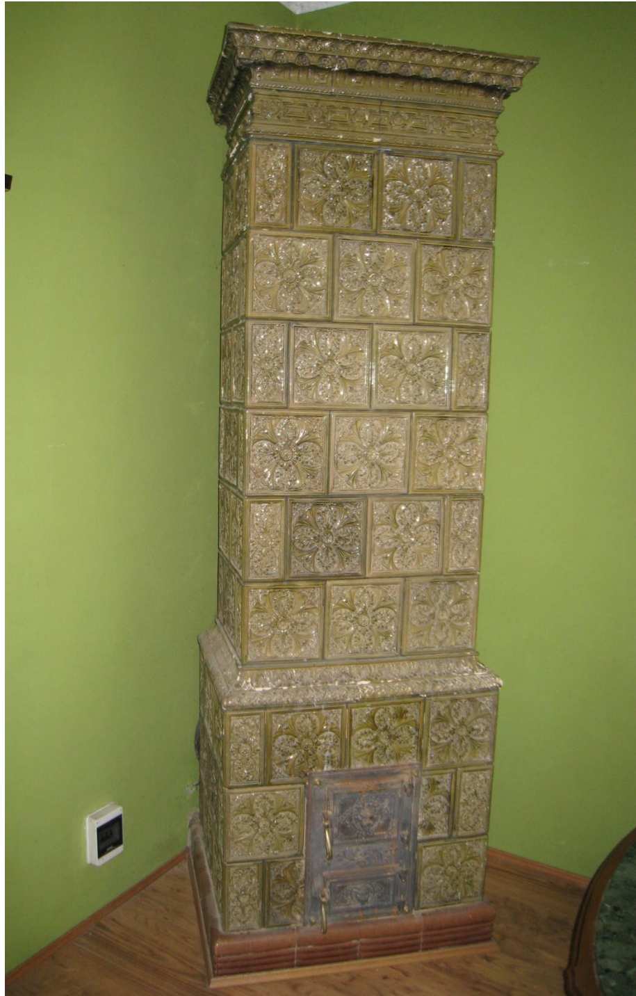
Fot. nr 9 – Kossakówka – Plac Kossaka 4, Kraków. Zdjęcie pieca nr 1, eklektycznego z firmy J. Niedźwieckiego wykonane przez dr arch. Jacka Chrzęszczewskiego w 2009 r. Widoczne różne odcienie szkliva w kolorze oliwkowym oraz nieoryginalna baza pochodząca z pieca modernistycznego w kolorze ciemnoróżowym, identycznym jak piec nr 2. Na dolnym profilu fryzu widoczne uszkodzenia.
