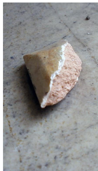
Fot. nr 10, 11, 12 – Kossakówka – Plac Kossaka 4, Kraków. Na górnym zdjęciu kafel licowy z dekoracją geometryczną oraz widoczna na odwrociu sygnatura spółdzielni „KAFEL”. Na dole po prawej stronie - odłamany fragment narożnika ukazujący budowę kafla – czerep z czerwonej gliny pokryty angobą ze szlachetnej białej glinki, która stanowi podłoże kremowego szkliwa. Na dolnym lewym zdjęciu odłamana krawędź kafla pieca nr 4 lub 5 wskazująca na to, iż cały kafel był odlany z białej mieszanki gliny. Te dwa fragmenty ukazują, że w początkowym okresie produkcji spółdzielni „KAFEL” (po 1927 r.) kafle mogły być produkowane w różny sposób. fot. Andrzej Karbowski – kwiecień 2021 r.
